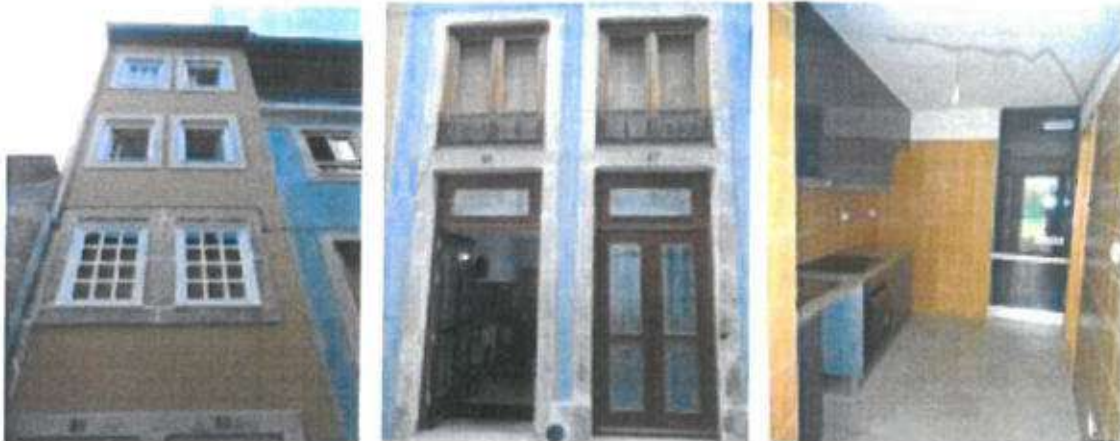
Fotografias 49, 50 e 51: Edifício da Rua Direita nº 91-97
