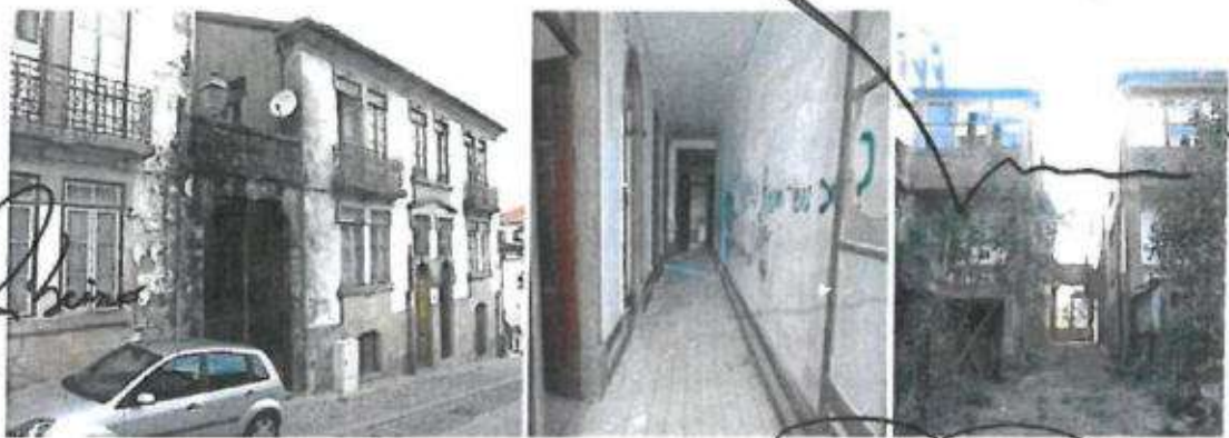
Fotografias 29, 30 e 31: Aspeto atual dos imóveis e do logradouro, respetivamente.
