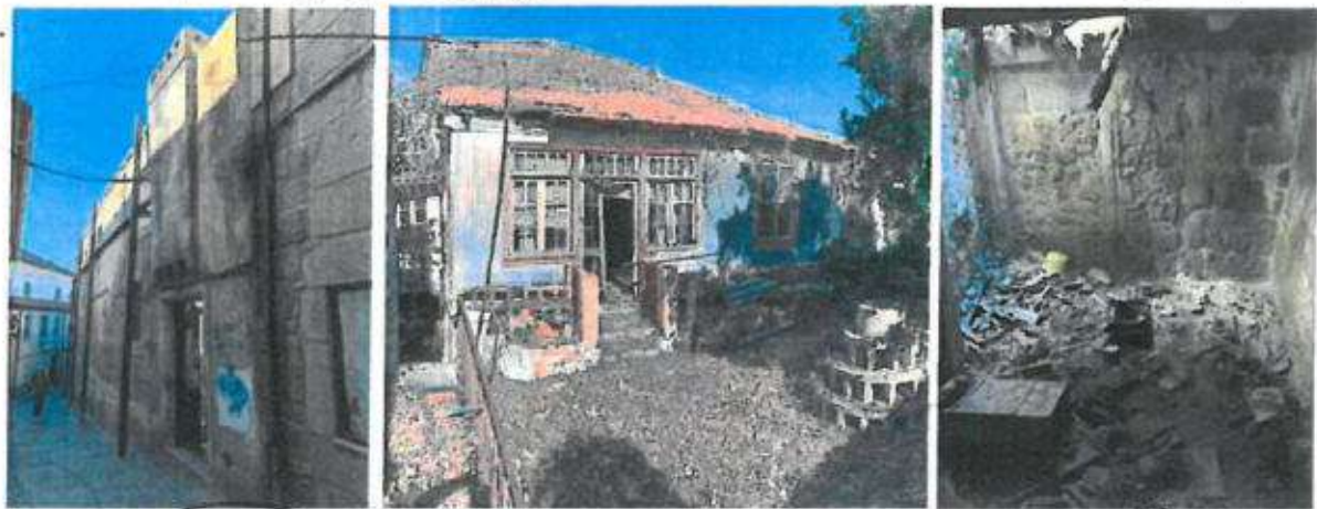
Fotografias 60, 61 e 62: Aspeto dos imóveis antes da intervenção
