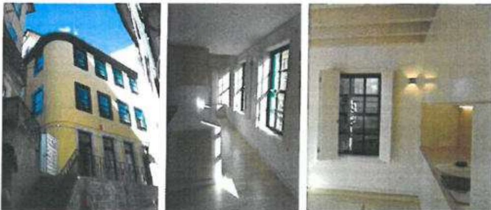
Fotografias 46, 47 e 48: Edifício da Rua Escura 11-17
