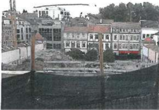
Fotografia 16: Aspeto da Praça 2 de Maio, durante a intervenção
