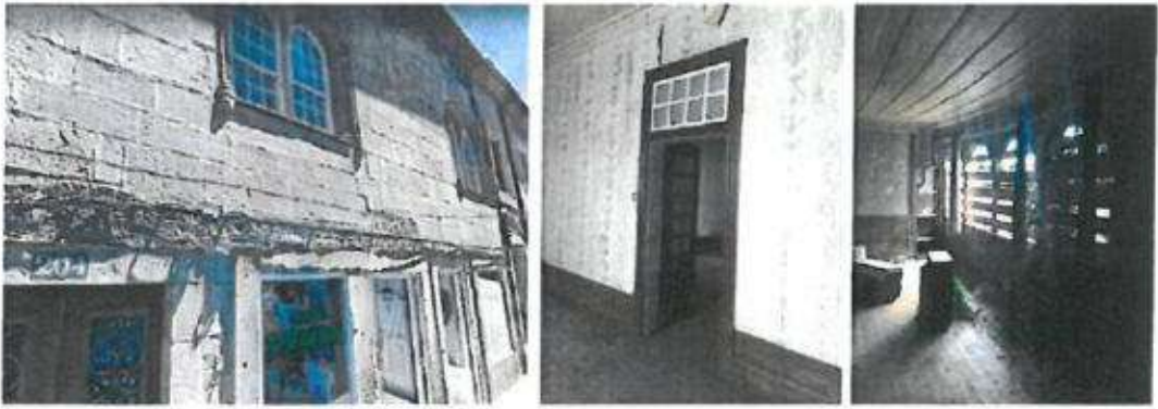
Fotografias 63, 64 e 65: Aspeto do imóvel antes da intervenção
