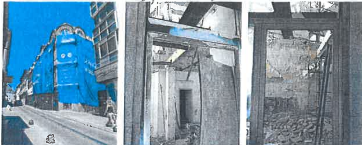
Fotografias 7, 8 e 9: Aspeto do imóvel durante a intervenção
