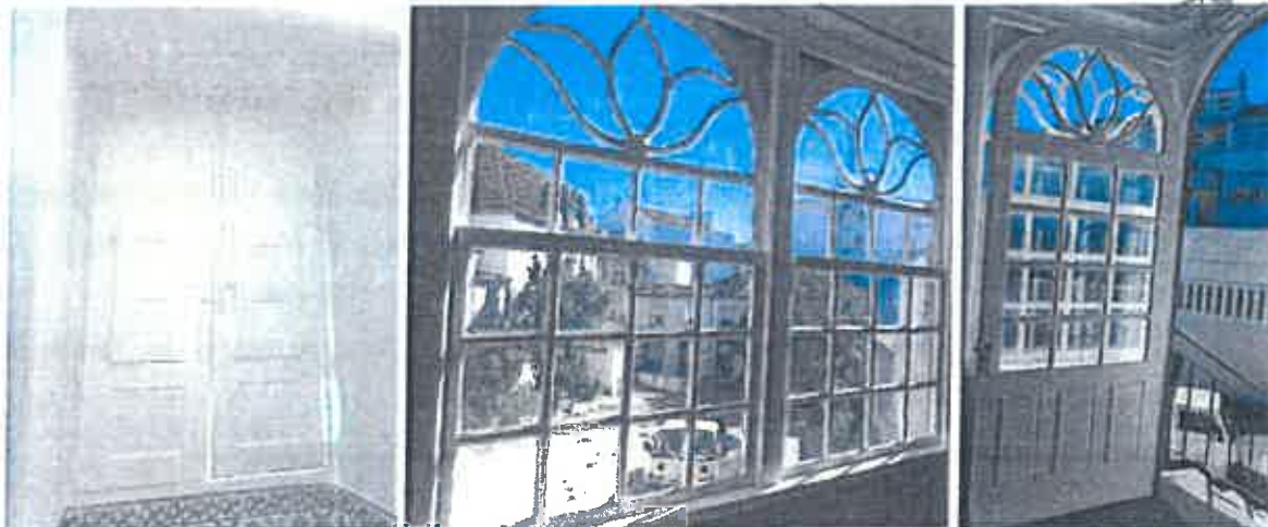
Fotografias 24, 25 e 26: Aspeto das caixilharias do Solar dos Condes de Prime, depois da intervenção
