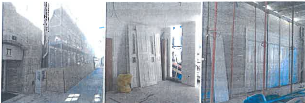
Fotografias 4, 5 e 6: Aspeto do imóvel durante a intervenção
