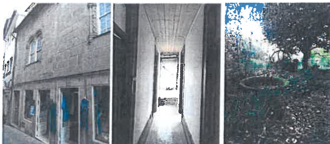
Fotografias 32, 33 e 34: Aspeto atual do imóvel
