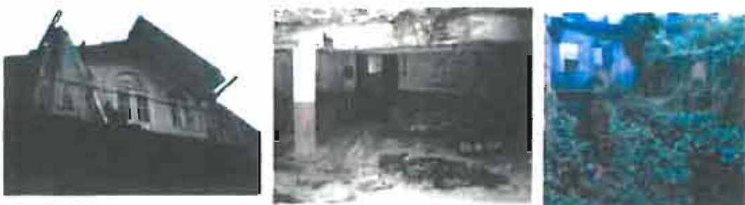
Fotos 30, 31 e 32: Aspectos do imóvel antes da intervenção
