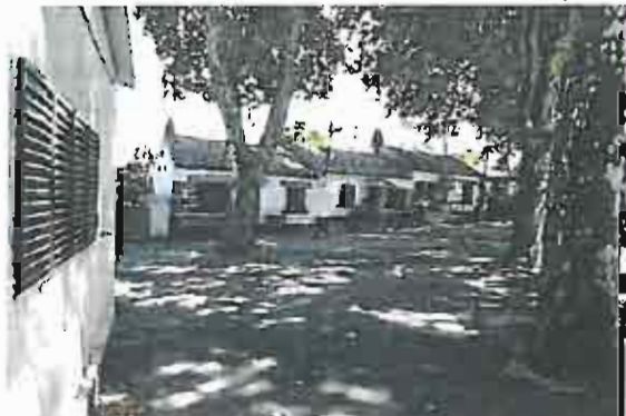
Foto 34: Estado atual do Bairro Municipal
