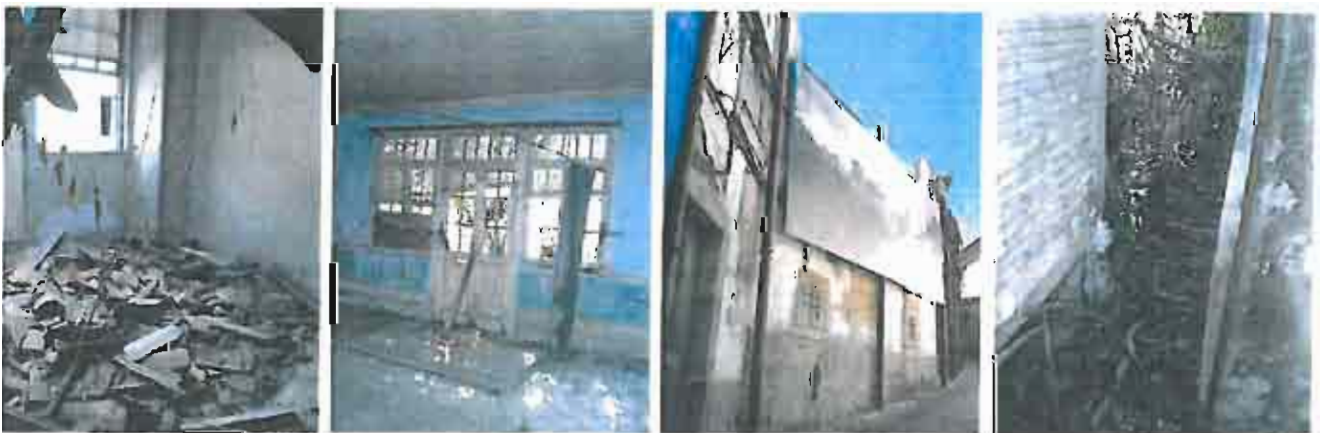
Fotos B3, B4, B5 e B6: Aspeto do imóvel antes da intervenção
