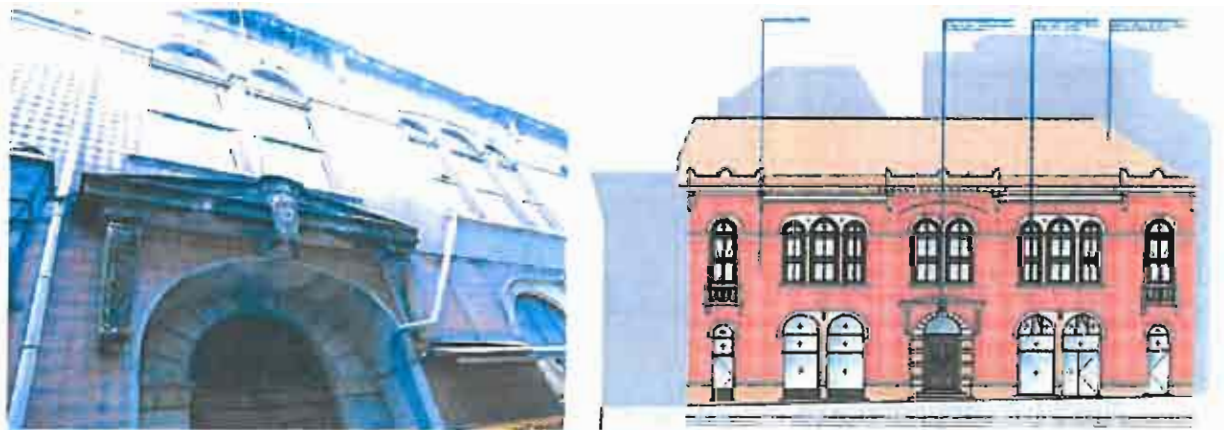
Fotos 79 e Imagem 7: Aspeto do imóvel antes da intervenção e respetivo projeto de obra
