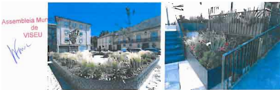
Fotos 39 e 40: Aspeto do Largo da Prebenda e do Pátio da Travessa de S. Lázaro, respetivamente, após as intervenções.
