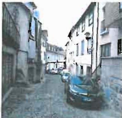
Foto 31: Antes da intervenção
