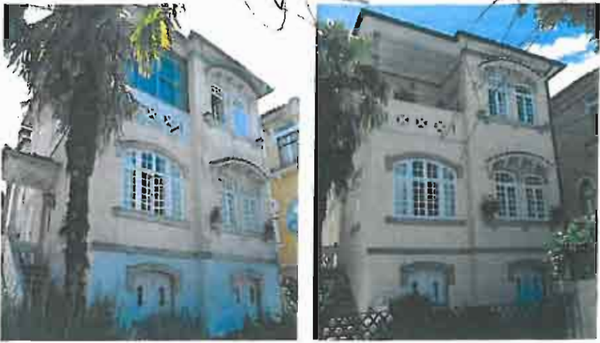
Fotos 57 e 58: Exemplos de reabilitação de fachadas com recurso ao Incentivo financeiro à recuperação de fachadas: Avenida José Relvas 8, antes e depois da intervenção
