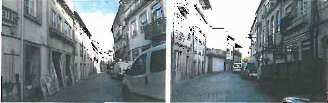
Fotos 100 e 101: Estado atual da Rua do Arco
