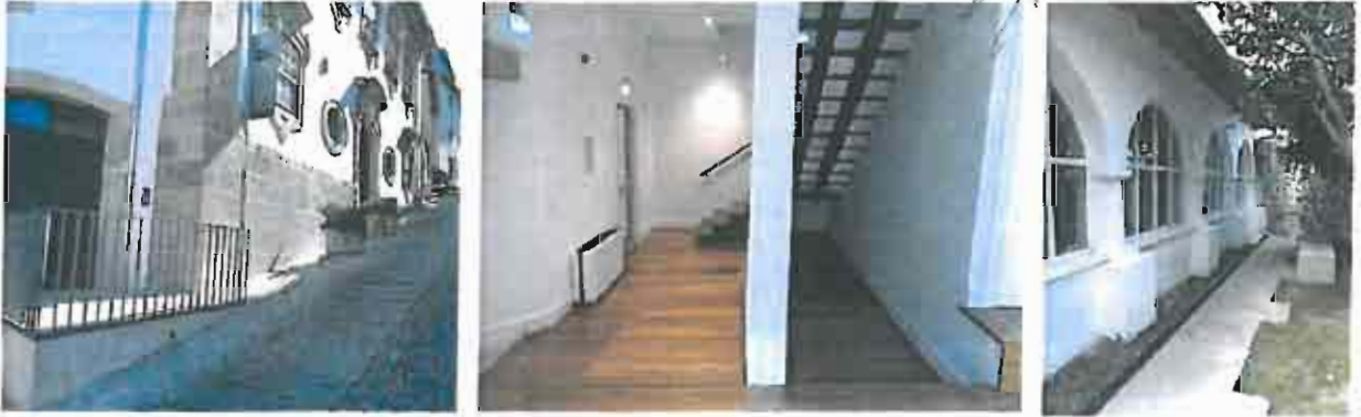
Fotos 76, 77 e 78: Edifício 'Casa da Calçada'
