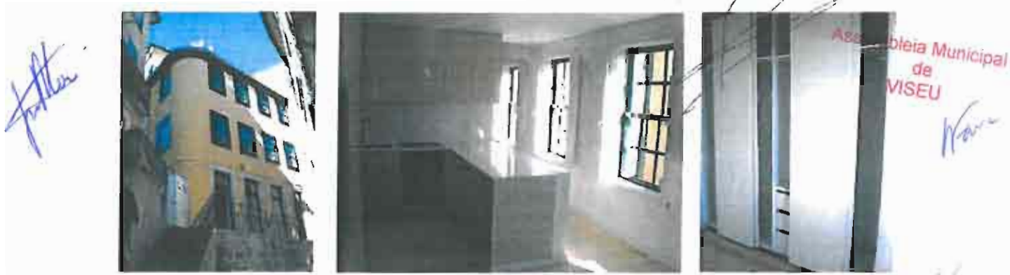
Fotos 70, 71 e 72: Edifício da Rua Escura 11-17
