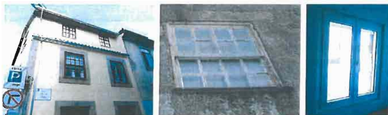
Fotos 10, 11 e 12: Exemplo de incentivo no âmbito do Programa de Correção Acústica: Fachada do Imóvel da Rua Silva Galo 11 depois da reabilitação e pormenor de caixilharia em guilhotina de madeira com vidro simples (antes da reabilitação) e instalação de caixilharias interiores classificadas, mantendo as exteriores (depois da reabilitação)
