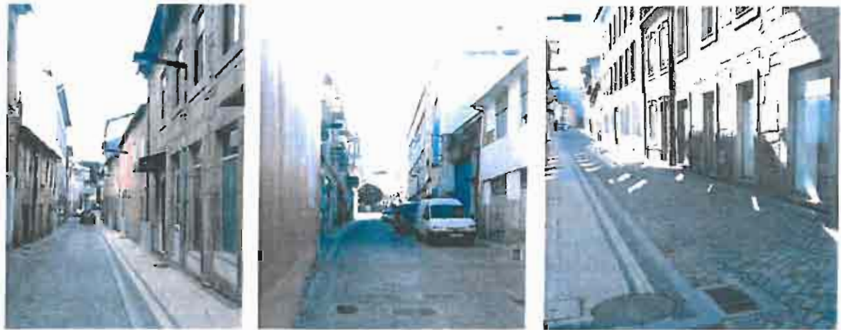
Fotos 28, 29 e 30: Aspeto do arruamento depois da intervenção
