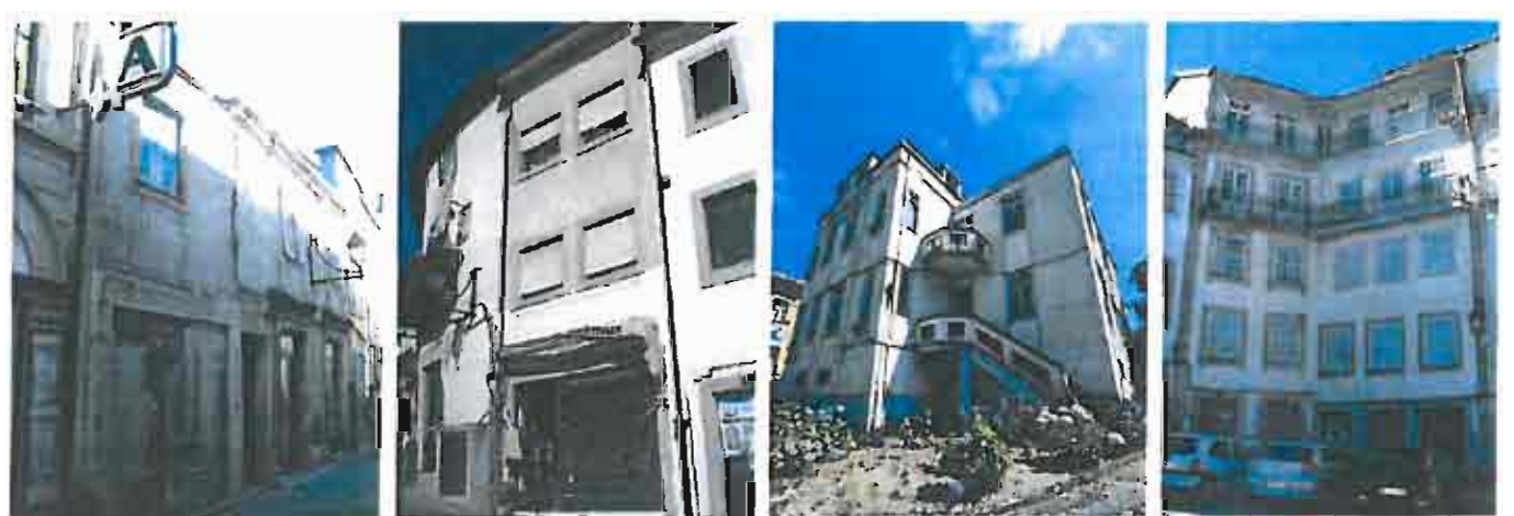
Fotos 4, 5, 6 e 7: Exemplos de imóveis para reabilitar, transacionados entre particulares na ARU: Rua Direita 83-89; Largo Mouzinho Albuquerque 79; Avenida José Relvas 7 e Largo da Misericórdia 26-34
