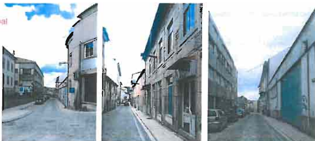
Fotos 95, 96 e 97: Estado da rua depois da intervenção
