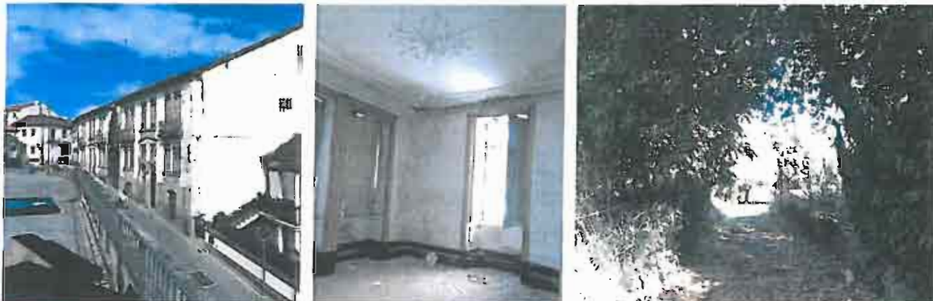
Fotos 87, 88 e 89: Prédios na Rua Silva Gaio e terreno a afetar a um novo parque de estacionamento
