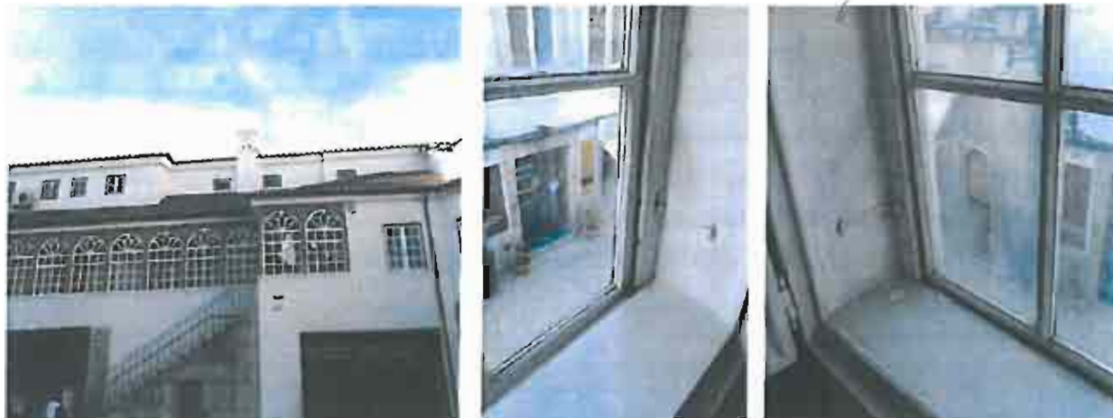
Fotos 45, 46 e 47: Caixilharias do Solar dos Condes de Prime
