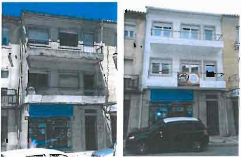
Fotos 59 e 60: Exemplos de reabilitação de fachadas com recurso ao incentivo financeiro à recuperação de fachadas: Largo Major Monteiro Leite 15, antes e depois da intervenção
