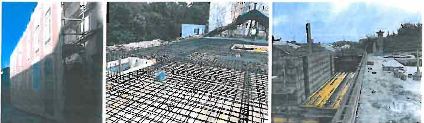
Fotos 25, 26 e 27: Aspeto do imóvel durante a intervenção
