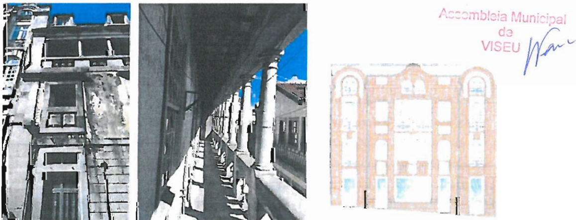
Fotos 84, 85 e Imagem 13: Aspectos do imóvel antes da intervenção e respetivo projeto de obra
