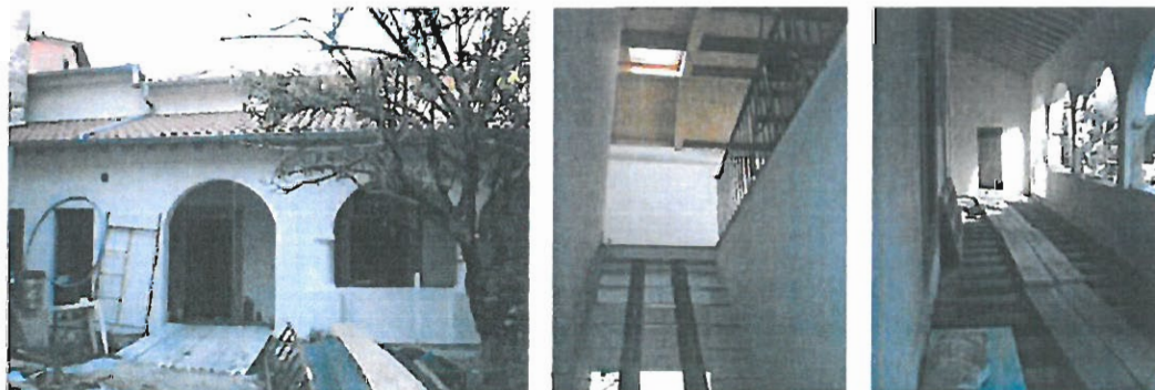
Fotos 79, 80 e 81: Aspectos do imóvel, durante a intervenção.
