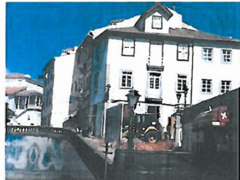
Foto 29: Durante a intervenção
