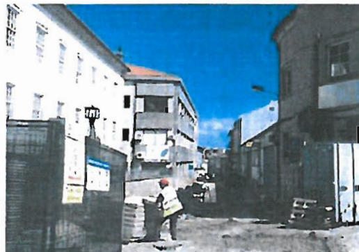
Foto 27: Durante a intervenção
