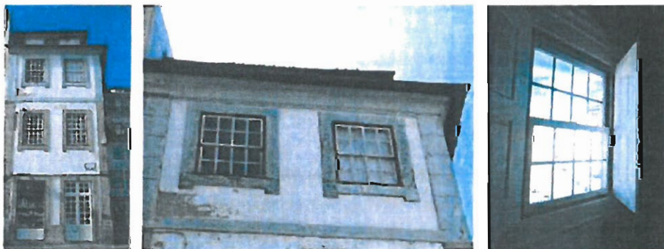
Fotos 53, 54 e 55: Fachada do Imóvel da Rua do Adro 21 e pormenor das caixilhariças em gullhotina com vidro simples (antes da intervenção ao imóvel) e substituição por caixilharia em gullhotina de vidro duplo, além de novas portadas Interiores (depois da obra de reabilitação)
