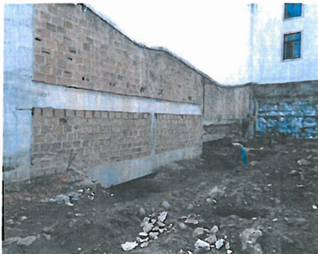
Foto 41: Trabalhos de ampliação do Teatro Viriato
