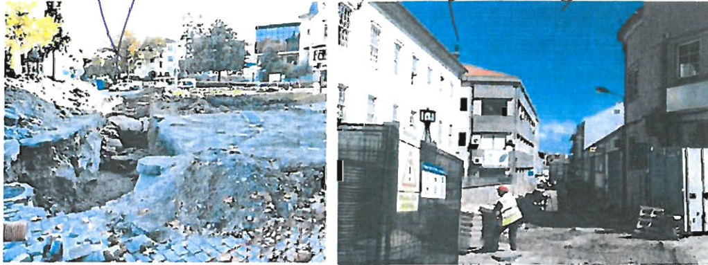
Fotos 105 e 106: Troço da muralha romana descoberta na Rotunda de Santo António e estado atual da intervenção na Rua João Mendes, respetivamente
