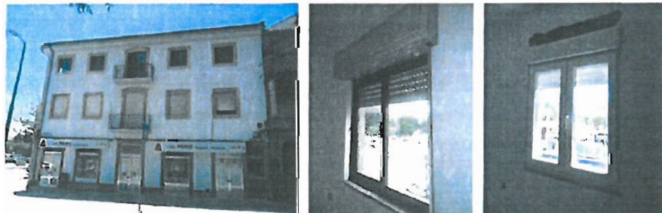
Fotos 56, 57 e 58: Fachada do Imóvel na Av da Bélgica 1-9, pormenor de caixilharia de vidro simples e substituição por caixilharia de vidro duplo
