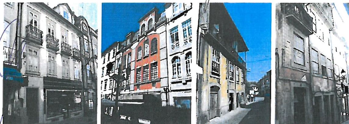
Fotos 1, 2, 3 e 4: Exemplos de Imóveis para reabilitar, transacionados entre particulares na ARU: Rua do Comércio nº 86; Rua da Paz nº 20; Rua do Arco nº 88-96 e Rua Augusto Hilário 50
