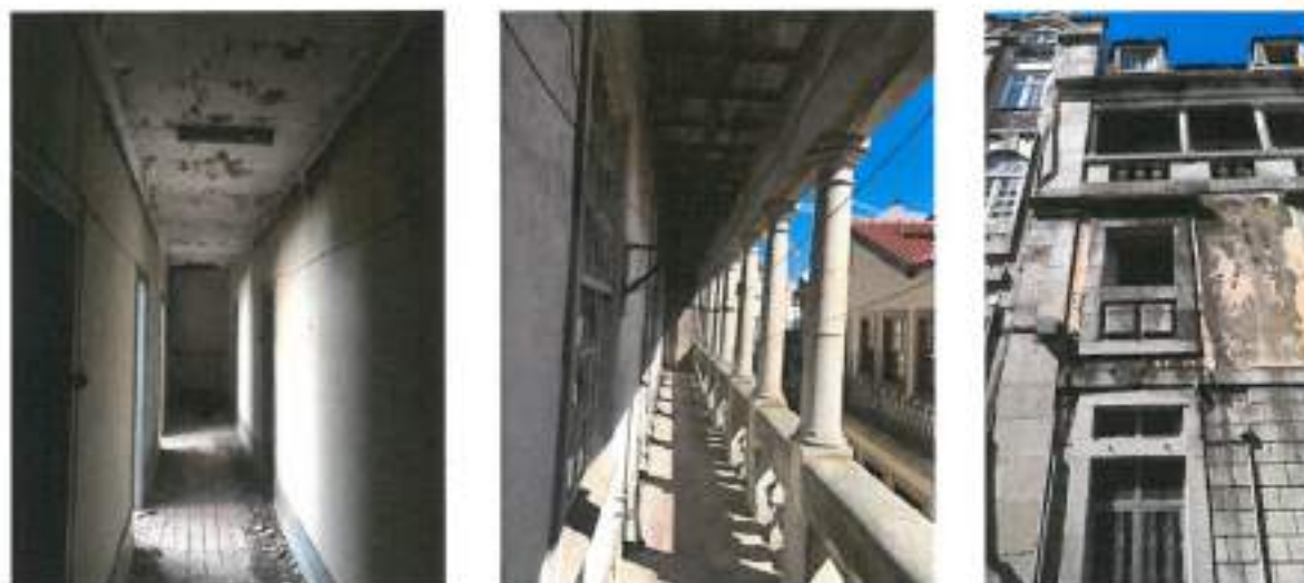
Fotografias 18, 19 e 20: Vista do Interior e do exterior do imóvel
