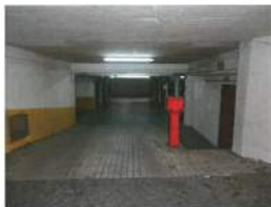
Foto 68- Equipamento de controlo das saídas
