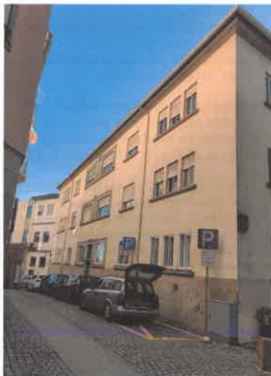
Alçado voltado à Rua do Carmo
