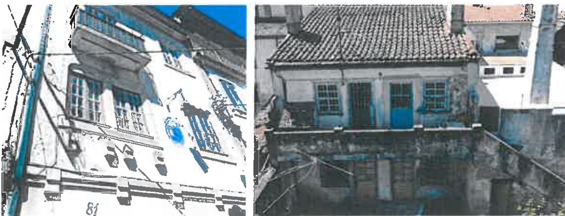
Fotografias 4 e 5: Aspeto atual do imóvel da Rua do Arco nº 81-83
